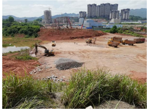
桥梁施工工地
