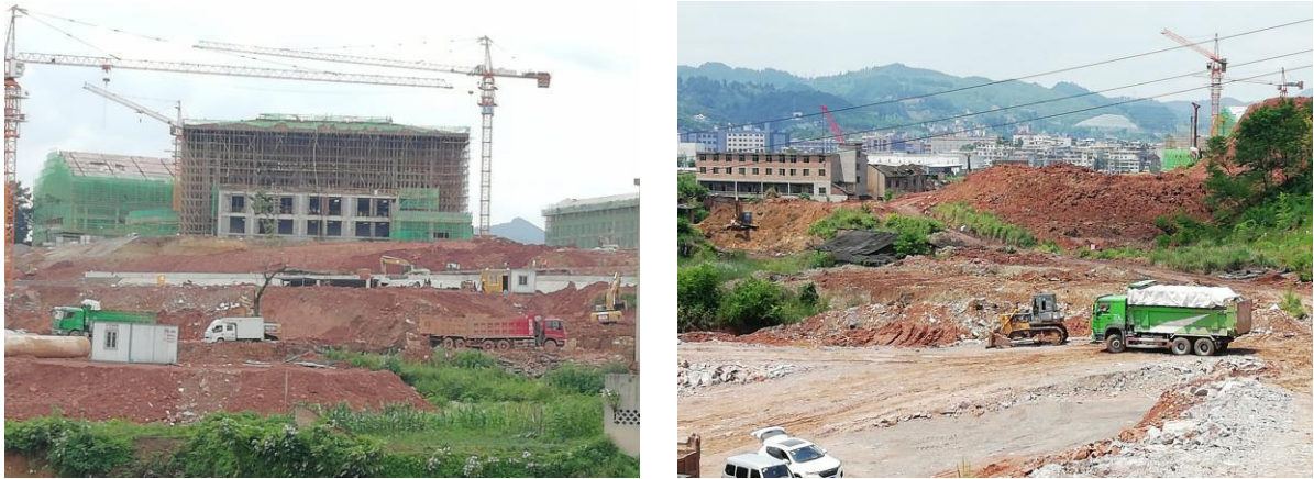
建筑施工工地
