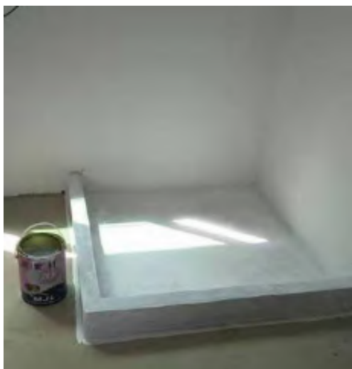
危废暂存间内部照片
