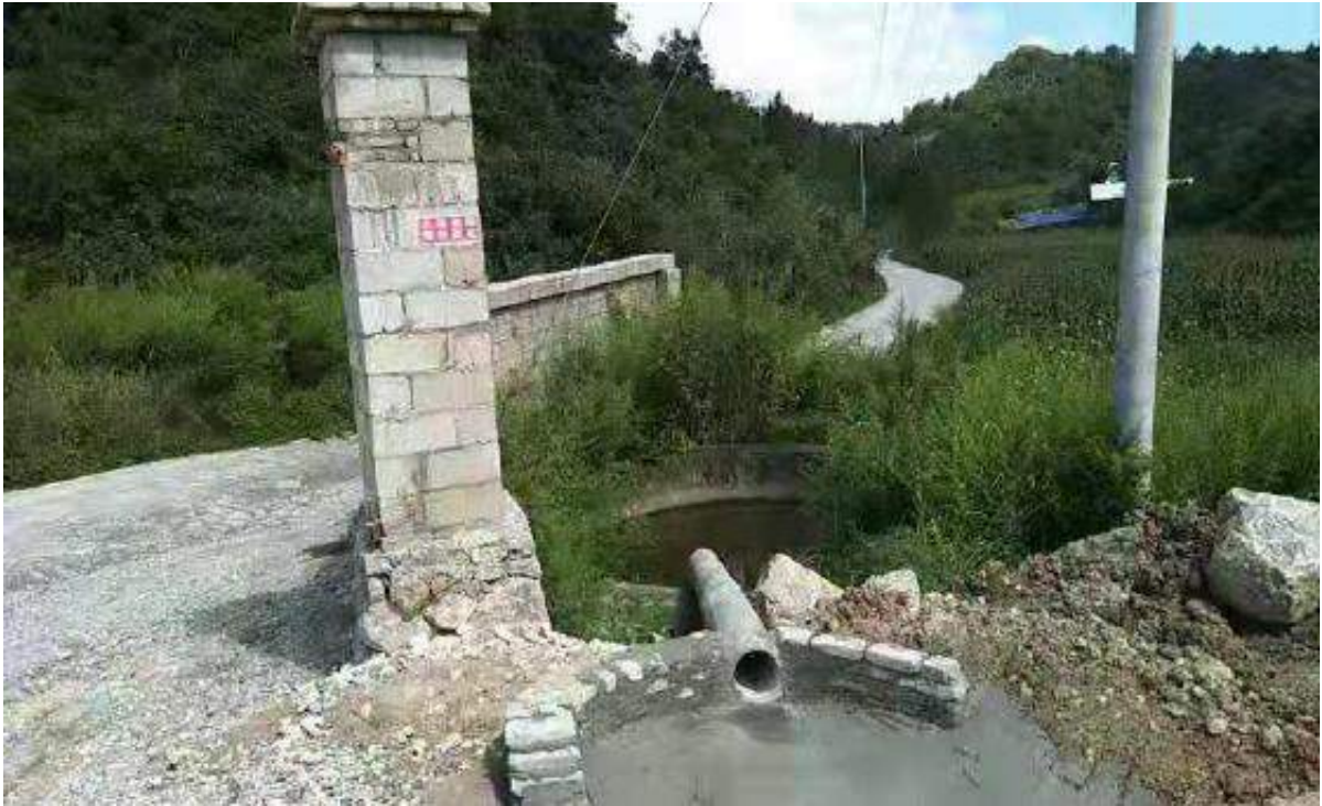
雨水收集池照片
