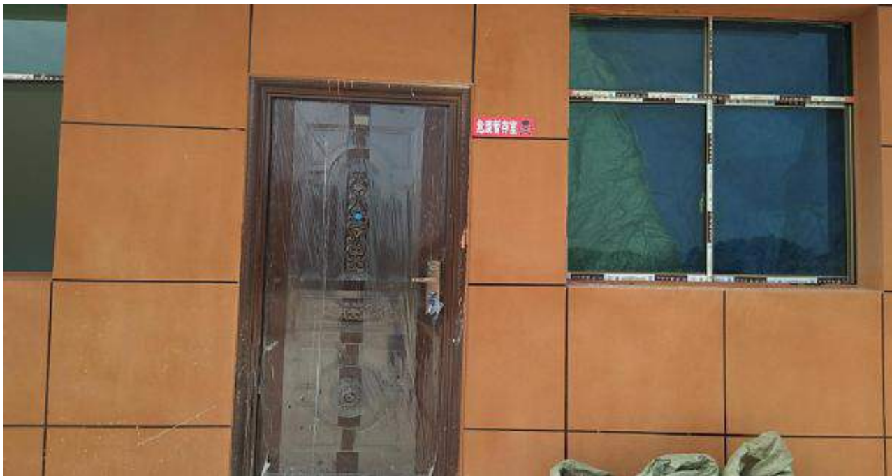
危废暂存间外部照片
