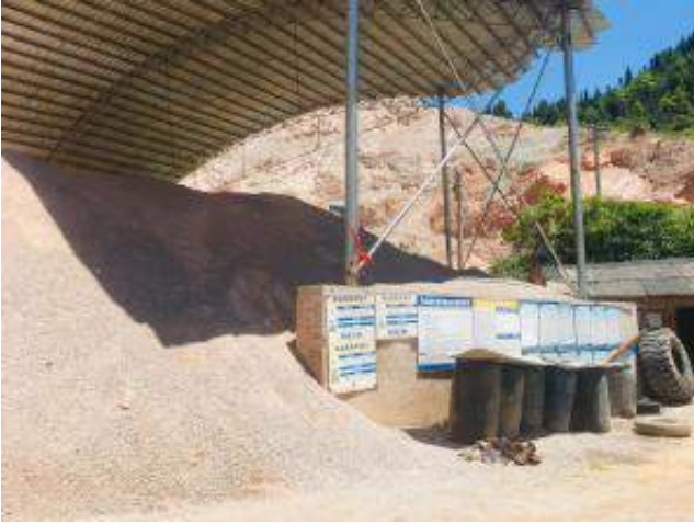
附图6、现场环保设施及措施照片
